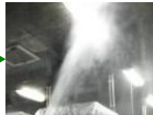
⑥高圧水散布し、汚れと 塗布薬剤を除去
