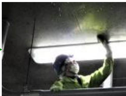
④錆がひどい箇所を 研磨パッドで研磨
