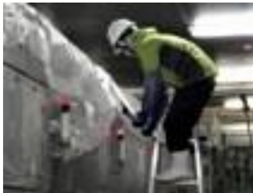
①清掃天井下の装置類を養生
