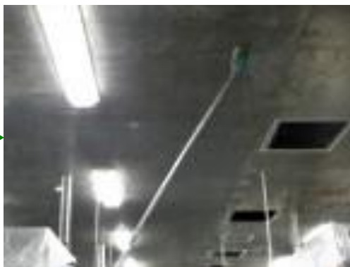
⑤研磨で除去出来ない 箇所に錆取り剤を 再塗布し、再研磨
