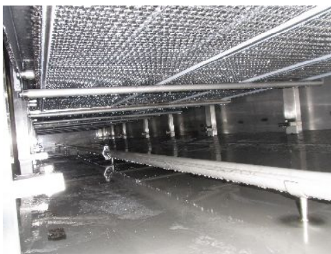
【庫内側 蒸気配管】
