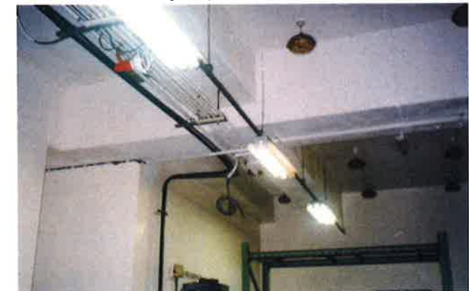
塗装完成写真
