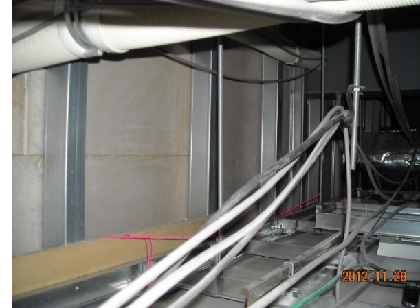
天井板の裏が結露し カビが発生したために 下に孢子が落下した例
