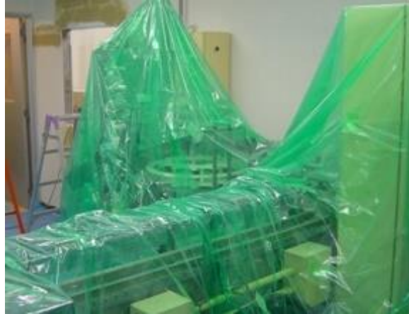
汚れ防止のための 養生を行ったために カビが発生した例
