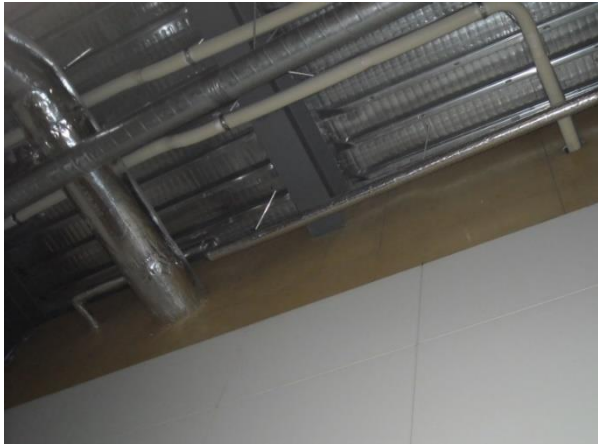
天井部分に塗装が されていないために カビが発生した例
